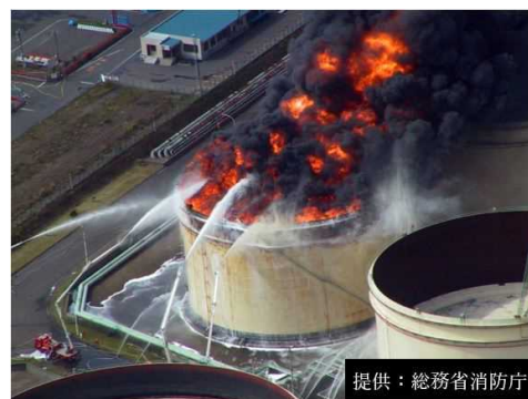
図3 大型タンク類の被害
