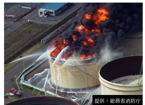
図3 大型タンク類の被害
