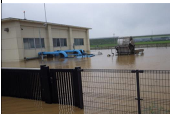
揚水機場の浸水（酒田市藤塚）
