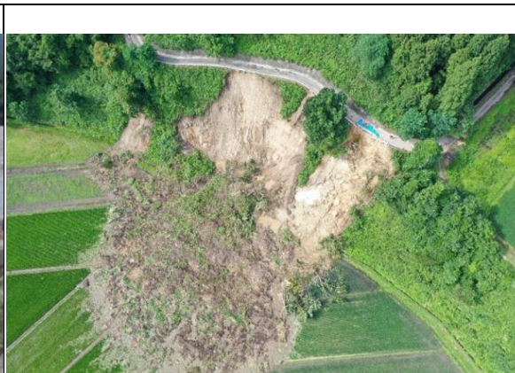
堰法面崩落（舟形町長沢）
