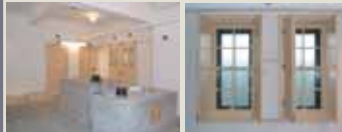
地震計(左写真中央)とハンガードア(左写真奥)3重の建具(右写真)
