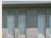
増築棟の窓廻り
